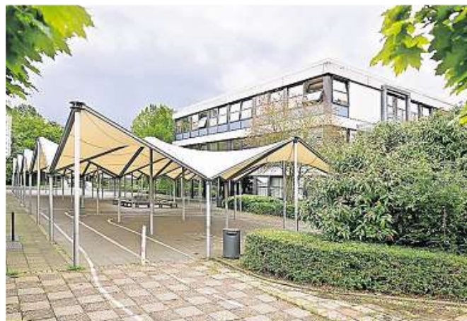
Die Bischöfliche Montessori-Schule hat auf ihrem Areal eine Grundschule, Gesamtschule, Kindergarten, Schwimmbad und Sporthalle.
