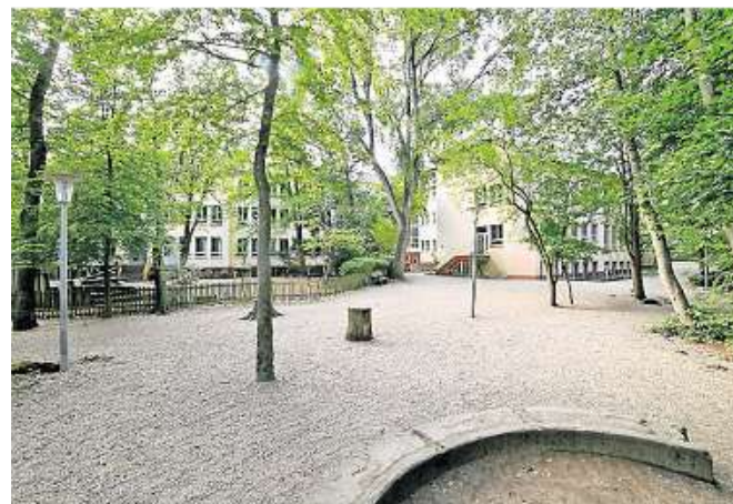
Die Freie Waldorfschule in Krefeld beherbergt auf ihrem Gelände auch eine Werkstatt. Das Zentrum wurde vor 50 Jahren errichtet.
